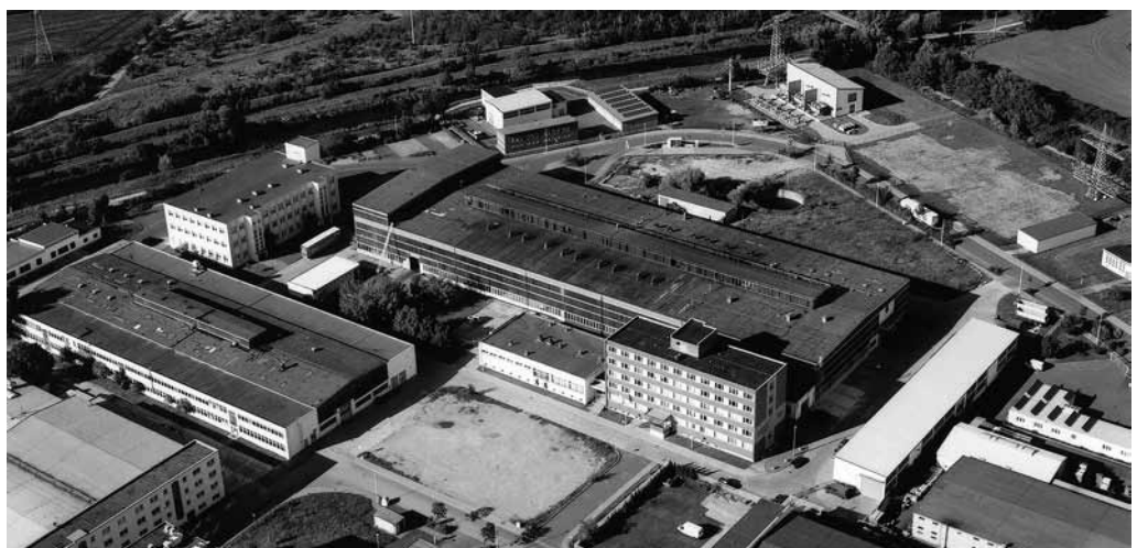
TRIMET-Werk in Sömmerda: Druckgießerei
